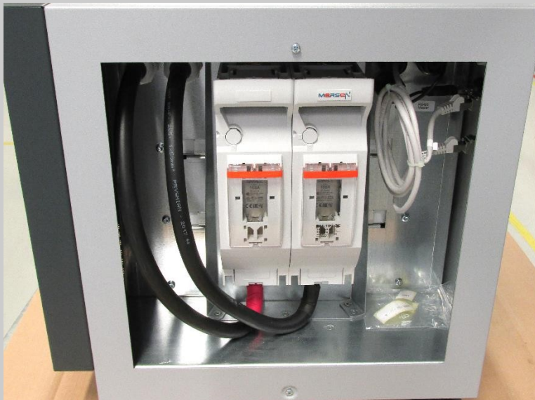
Figura 4-7: Sistem de stocare a bateriei, vedere laterală a carcasei deschise
