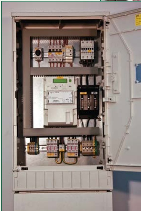
Zählerverteiler
