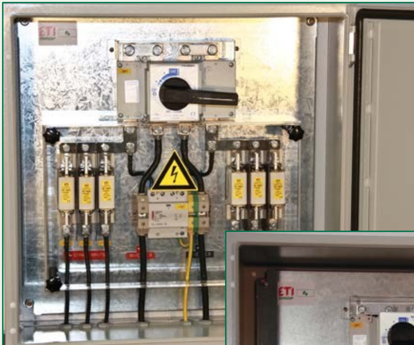
Cutie de jonctiune CC (siguranțe CH gPV)
