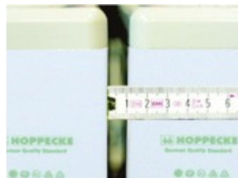
Fig. 5-14: Distanță de 10 mm între baterii
