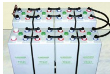
Fig. 5–15: Utilizarea conectorilor în serie și a conectorilor în trepte
