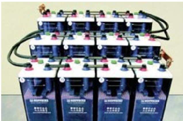
Abbildung 6.6.5-1 - Einsatz von Reihen- und Stufenverbindern
